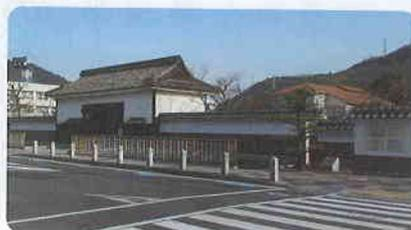
軒丸瓦の文様には戸川氏の家紋である「三本杉」を使用している。土蔵造の建物で、柱は方柱を使用。八双金具、乳金具を打った両開きの板唐戸を入れ、その両脇は潜門にしている。門の西側には一間の出格子窓、同じく東側には半間の窓を設け、壁面には窓の高さまで下見板を張ってある。ちなみにこの門は後世の道路拡幅工事に伴って、若干北にずらして移築されている。現在門の前にある堀は、その時に築かれたものであり、県庁の遺構ではない。
